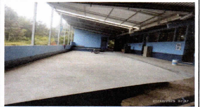
Foto 4: cambio de losa de patio, ya reparada.
