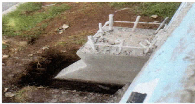
Foto 3: Soporte de muro perimetral, zapatas.
