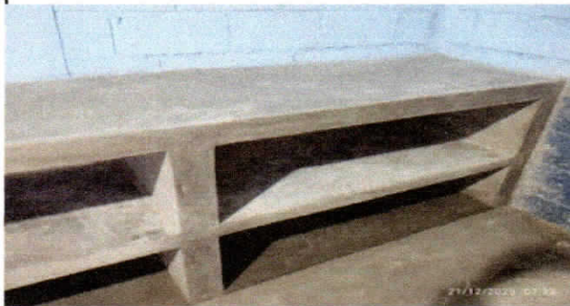
Foto 1: SUSTITUCION DE COCINA MEJORADA EN MAL ESTADO POR MESA DE CONCRETO.
